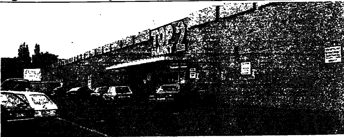
Auf der grünen Wiese vor den Toren der Stadt schließen phantasielose Flachbauten wie Pilze aus dem Boden. Architekten und Städteplaner schlagen Alarm. „Rischarts Backhaus“ mitten in München (unten) halten sie hingegen für beispielhaft.
